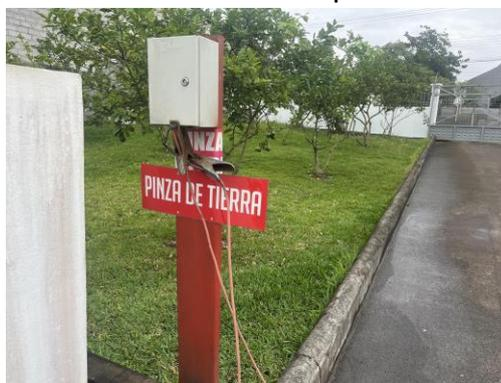
Foto No. 11 Conexión a tierra pinza autotankue
