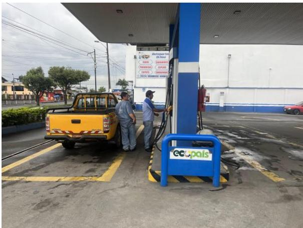
Las islas de despacho de combustible, está construida de concreto, tienen una altura superior a los 15 cm. con respecto a la pista, se encuentra en excelentes condiciones, pintadas y señalizadas, en los extremos tienen protecciones, para evitar colisiones de vehículos contra los surtidores, la pista de despacho de combustible se encuentra construida de hormigón, y no existen fisuras, lo que evita que los liqueos de combustible se filtren al suelo.
